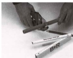
1. Rohr mittels Kunststoffschere oder Rohrabschneider rechtwinklig ablängen
